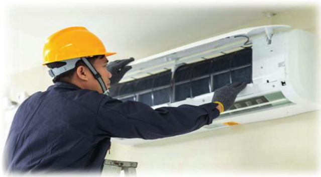
Ilustración 7. Mantenimiento de aire acondicionado
